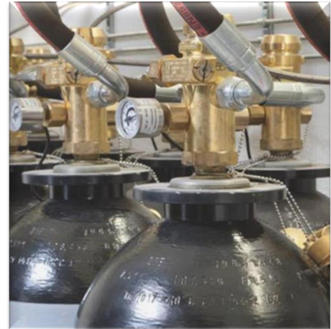
L'utilisation d'un système d'extinction régulé au lieu d'un système conventionnel réduit le niveau de bruit. ***Les essais ont montré qu'un débit massique lissé au cours du temps de décharge a mené à une réduction de bruit d'environ ~ 3dB.***
